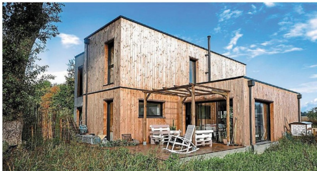
Des matériaux locaux et biosourcés ont été choisis pour l'ossature et le bardage bois.
